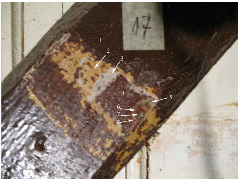
12. Krzyżak balustrady empory od strony zewnętrznej (p.17). Widoczne uwarstwienie: 1. warstwa malarska ciemnobrązowa, 2. warstwa malarska ugrowa, 3. warstwa malarska szarobiała, 4. warstwa malarska brązowa, 5. warstwa malarska szarzielona, 6. warstwa malarska siena naturalna, 7. warstwa malarska siena palona (oryginalna), 8. drewno.
