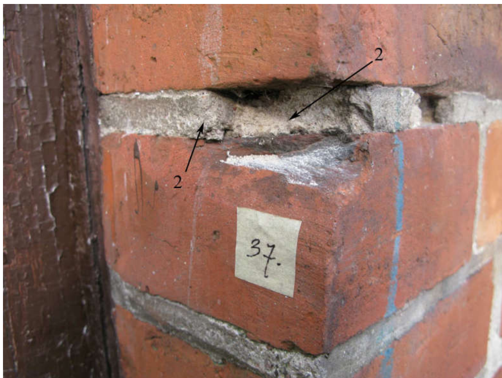
26. Elewacja frontowa. Widoczne: 1. spoina, 2. fuga.
